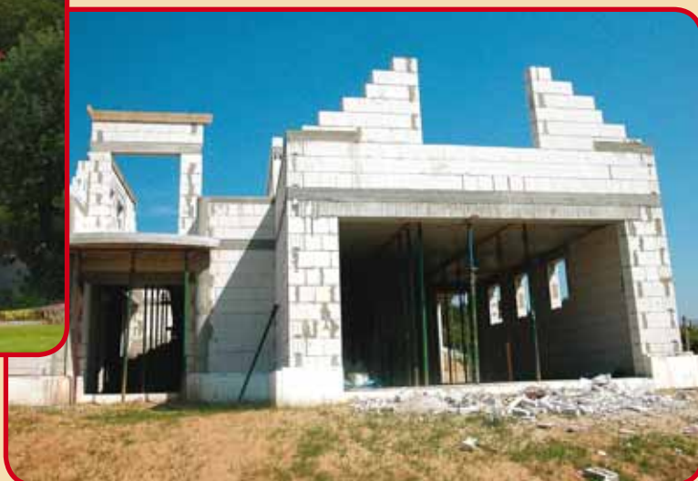
FÁZE VÝSTAVBY KMB SENDWIX - BZENEC
